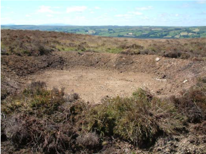
Ffigur 3. Ar y chwith: Pwll newydd sy'n dangos mor serth oedd glannau'r pwll. Ar y dde: Cafodd rwbel ei ollwng o amgylch ymyl y pyllau newydd gan greu min a oedd yn atal dŵr wyneb ffo rhag mynd i mewn iddynt. Mae'r llinell o ddotiau glas yn dangos llwybr dŵr wyneb ffo o ddalgylch posibl y pwll – ond cafodd dalgylch y pwll ei leihau'n sylweddol – mae'r llinell o ddotiau coch yn dangos dalgylch gwirioneddol y pwll . (Ffotograffau: Pond Conservation)
