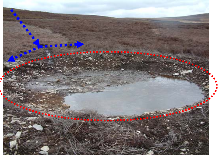
Ffigur 3. Ar y chwith: Pwll newydd sy'n dangos mor serth oedd glannau'r pwll. Ar y dde: Cafodd rwbel ei ollwng o amgylch ymyl y pyllau newydd gan greu min a oedd yn atal dŵr wyneb ffo rhag mynd i mewn iddynt. Mae'r llinell o ddotiau glas yn dangos llwybr dŵr wyneb ffo o ddalgylch posibl y pwll – ond cafodd dalgylch y pwll ei leihau'n sylweddol – mae'r llinell o ddotiau coch yn dangos dalgylch gwirioneddol y pwll . (Ffotograffau: Pond Conservation)
